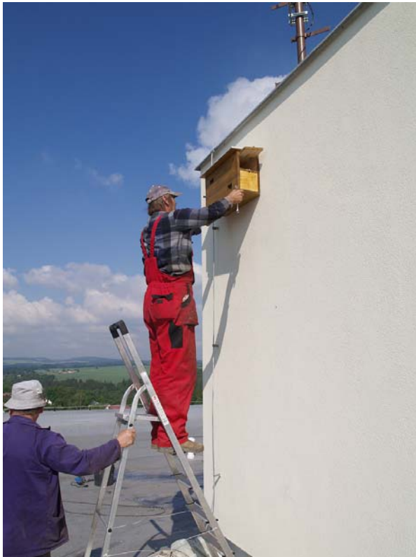
Zavěšování budek pro rorýse na strojovně panelového domu.
